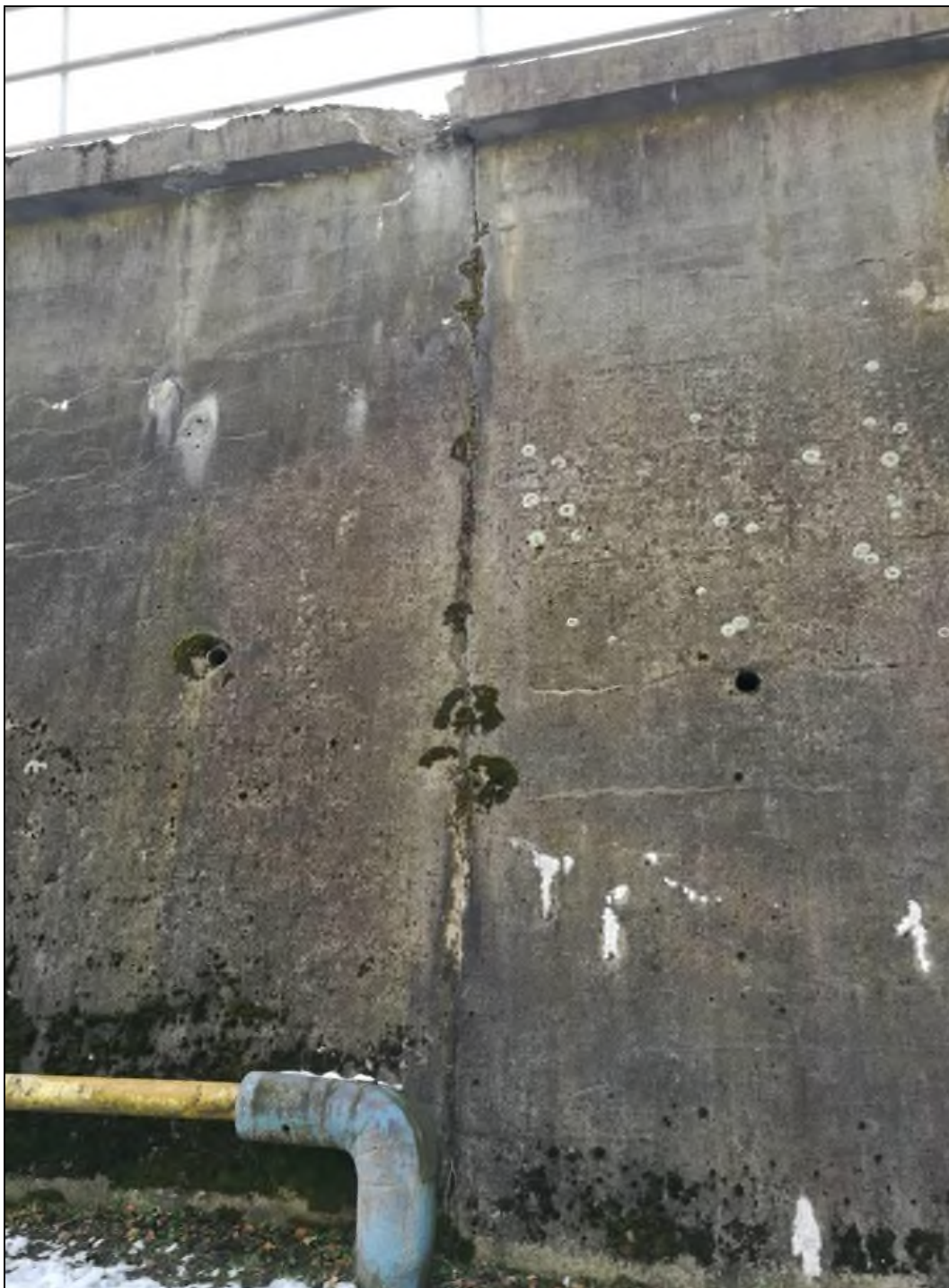
Obr. č. 9 - pohled na dilatační spáru v betonové části zdi - římsa s opady betonu
