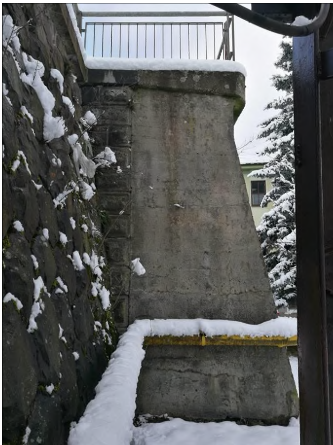
Obr. č. 10 - pohled na připojení betonové ke kamenné části zdi
