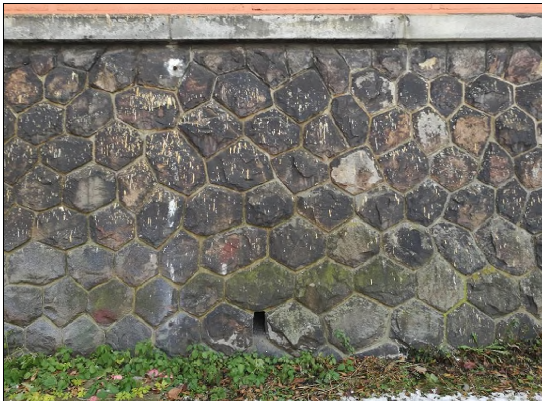
Obr. č. 6 - pohled na odvodňovací otvor v patě zdi
