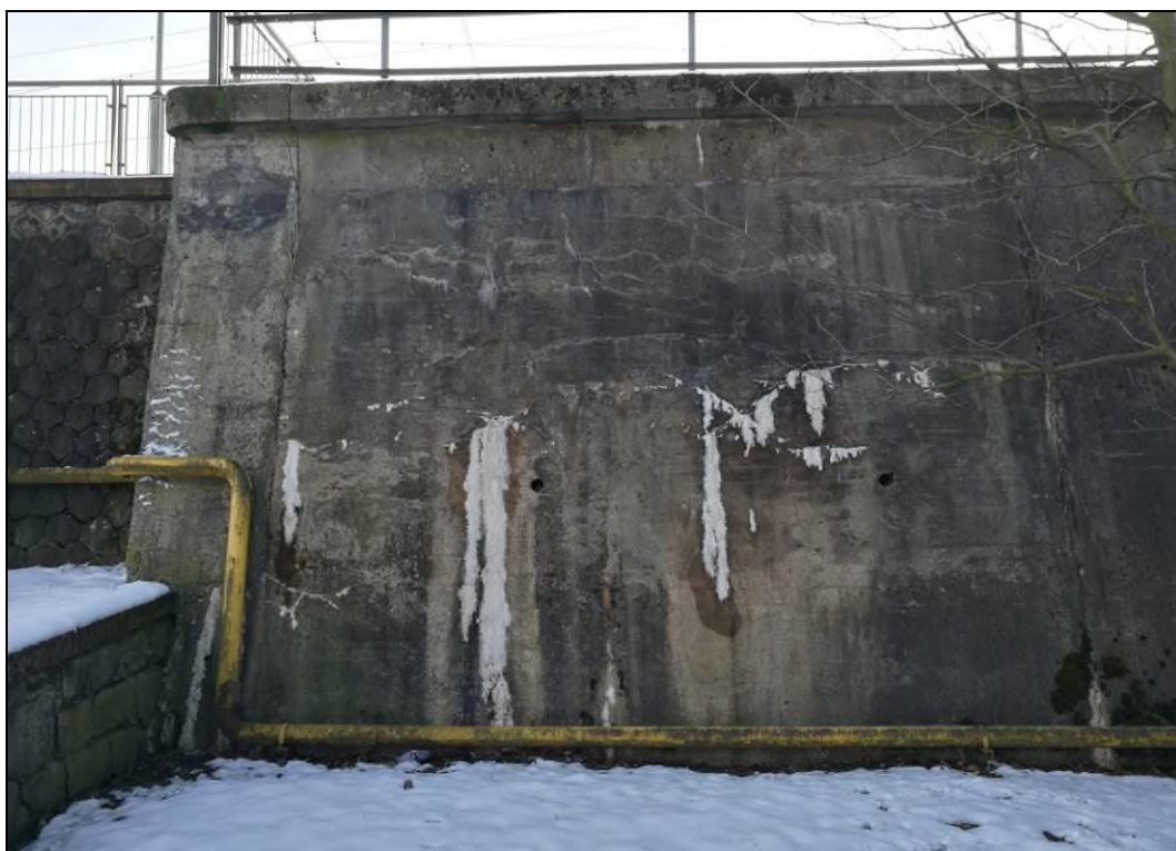
Obr. č. 7 - pohled na betonovou část zdi - vlasové trhliny v dříku zdi, doprovázené průsaky s vápennými usazeninami
