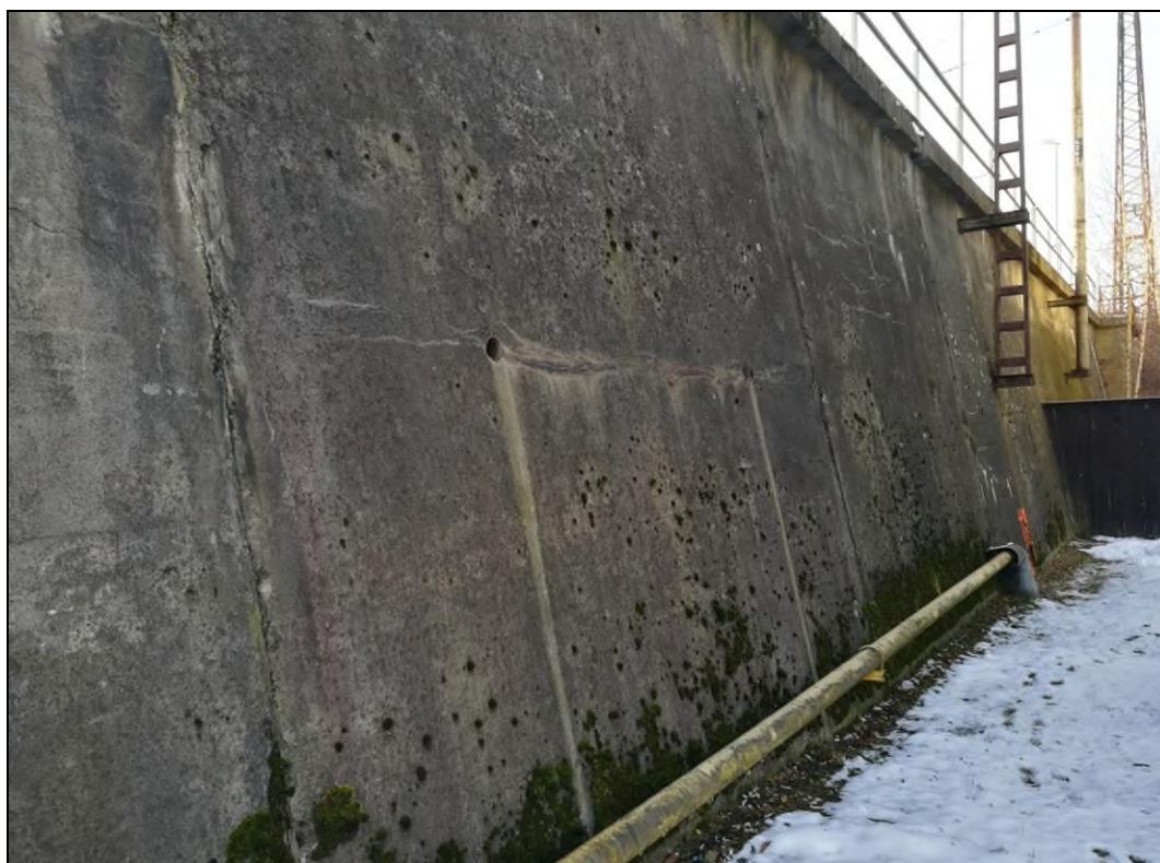
Obr. č. 8 - pohled na odvodňovací otvory v cca polovině výšky zdi
